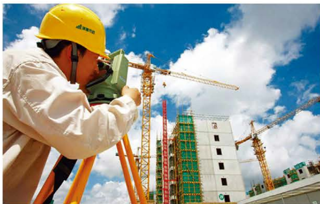
装配式建筑现场测量
