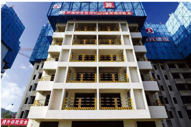
珠海金湾西湖天玺湾项目（装配式建筑）
