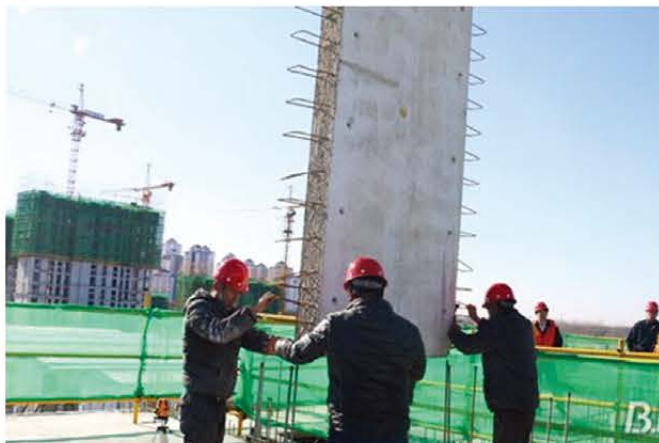
预制构件现场吊装
