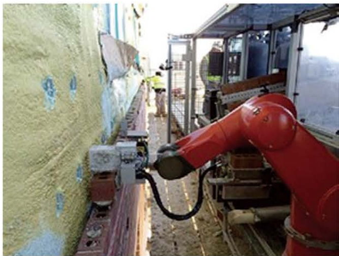
机器人砌筑技术应用场景
